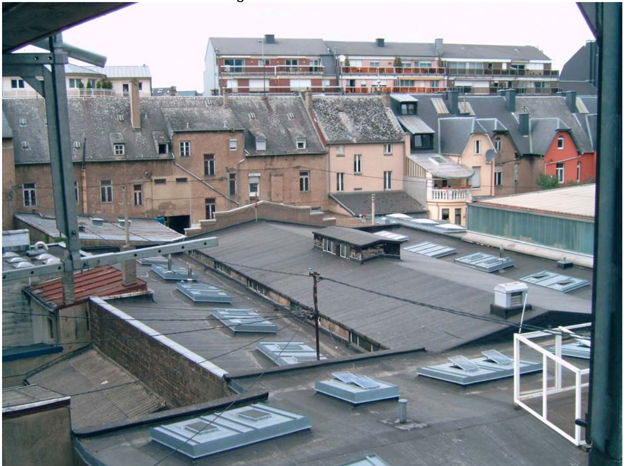
Ambiance de l'arrière des maisons vis-à-vis de la cour industrielle
