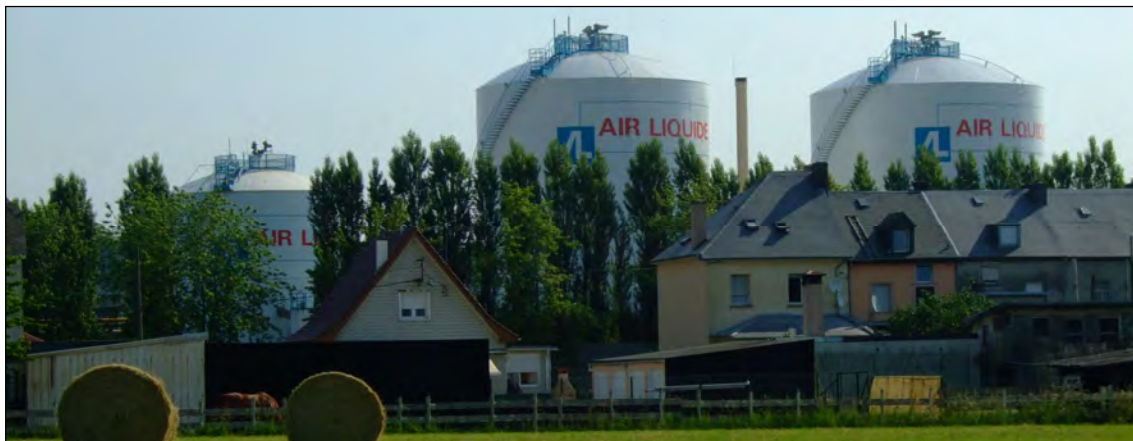
Illustration 99 In direkter Nachbarschaft zur Wohnbebauung errichtete Flüssiggas-Behälter im Stadtteil „Belval“
