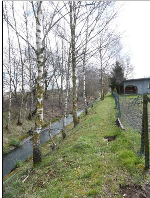
Abbildung 10: Kanalisierter Verlauf des Dipbech
