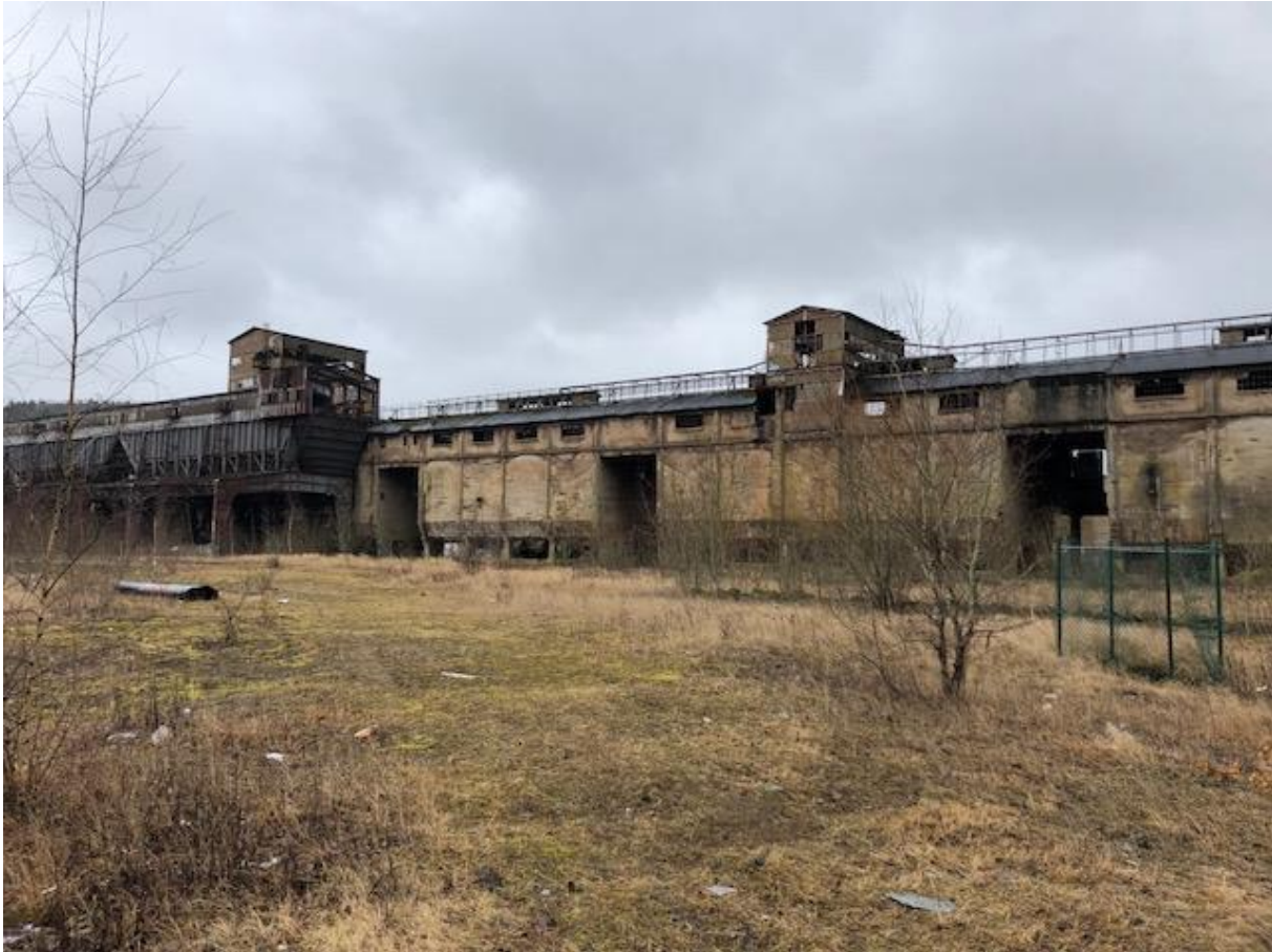
Abbildung 3: Alte Gebäudestrukturen im Untersuchungsgebiet
