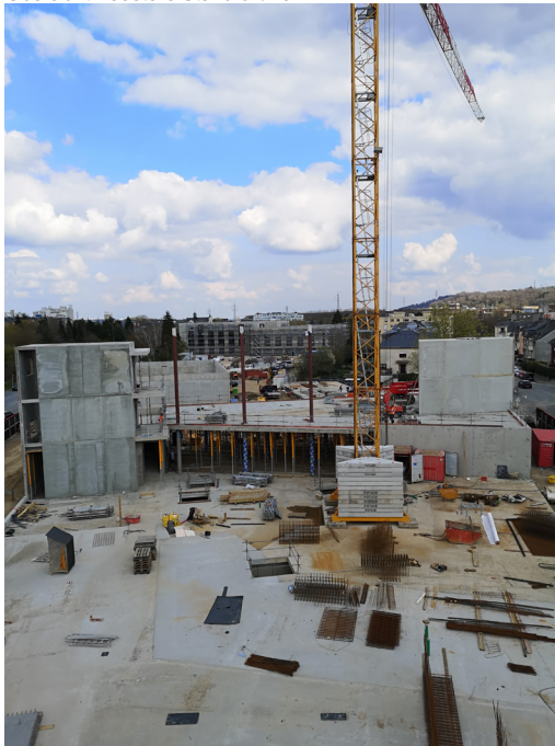
Übersicht Baustelle Stand 07/2021
