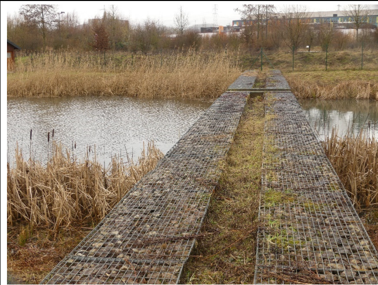
Gabionenmauer zwischen den Retentionsbecken
