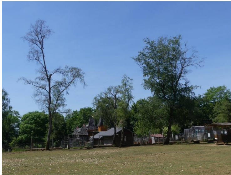
Übersicht aus Richtung Süden, links stark geschädigte Birke
